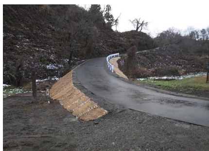
大仙市 八乙女公園（管理道整備）
